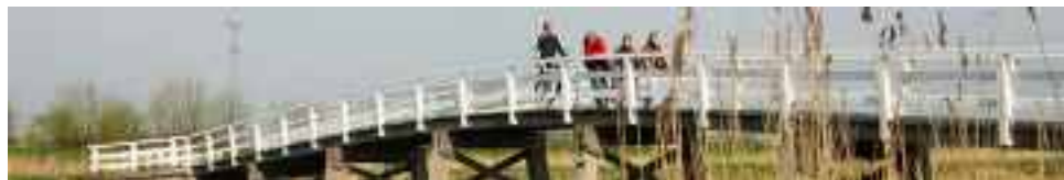
Beklimming van de fietsbrug in de Hoeksche Waard (Kinderdijk)
